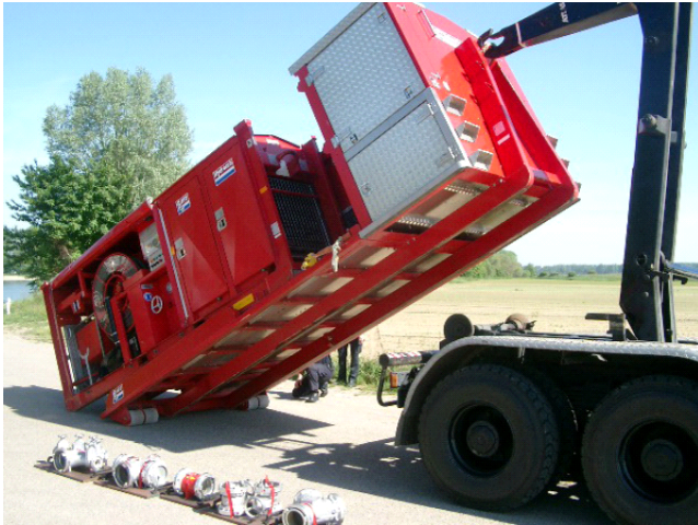
그림 18. 용수취수지점에 펌프세트를 설치 중인 HFS
